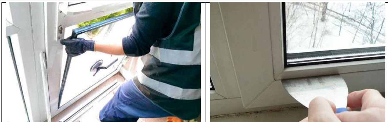
Рисунок 3.1 – Заміна склопакету вікна
